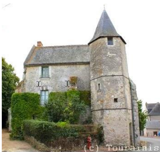
Fig.6 - Cette chapelle existe encore, au n° 53 de la rue Haute, logis flanqué d'une tour polygonale d'escalier, porte en anse de panier (cliché Christian Nicolas).
