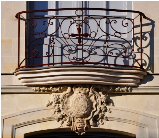
Deux ornements de la façade sur jardin : un garde-corps en ferronnerie et une guirlande de fleurs dans le pur style rocaille.
