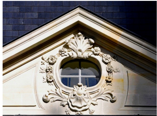
La façade sur la rue de la Psalette, le pavillon central et l'œil de bœuf.
