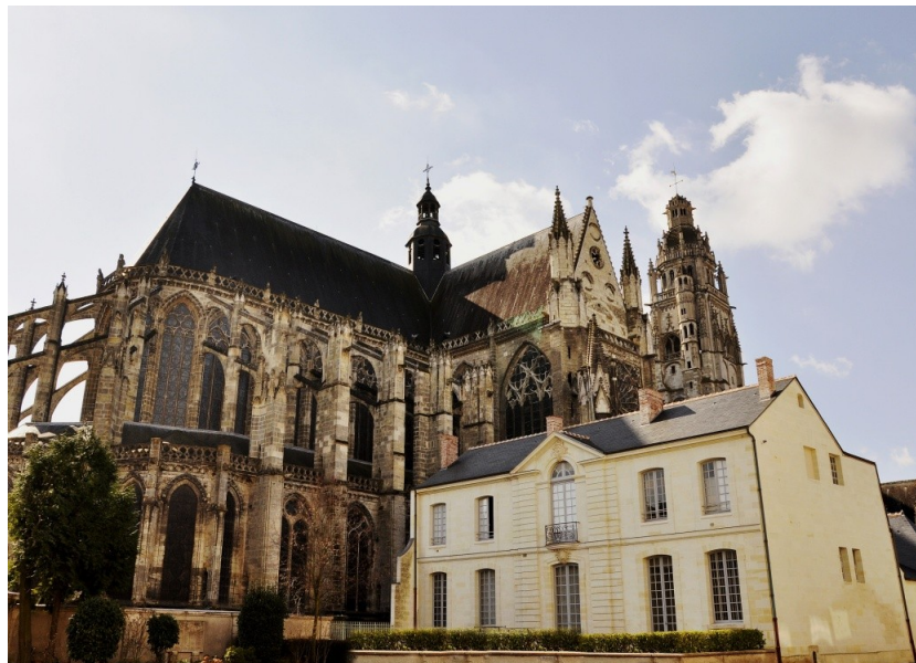
La façade donnant sur la cour du lycée. Initialement, elle s'ouvrait sur le jardin.
