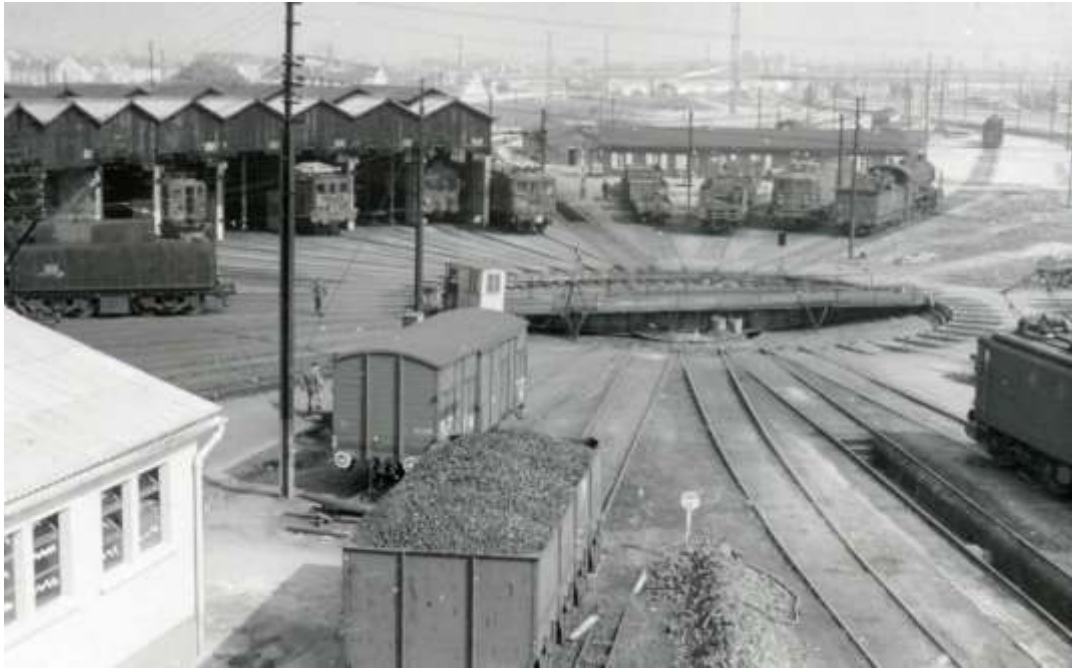
Fig. 5 – Vue des remises pour machines électriques, avec leur pont tournant (vers 1950 ?).
