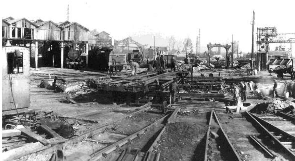
Fig. 3 – Remise en état du pont transbordeur après les bombardements de 1944 (1945)
